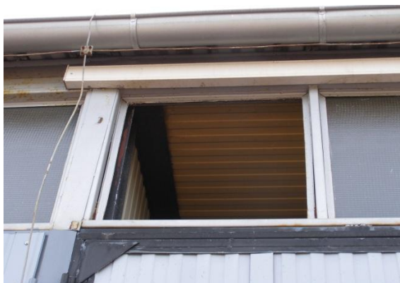
Fot.nr.1. Widok okno przeznaczone do uzupełnienia płytą plexi.
