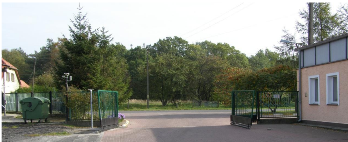
Fot.nr.1. Istniejąca brama przeznaczona do demontażu.
