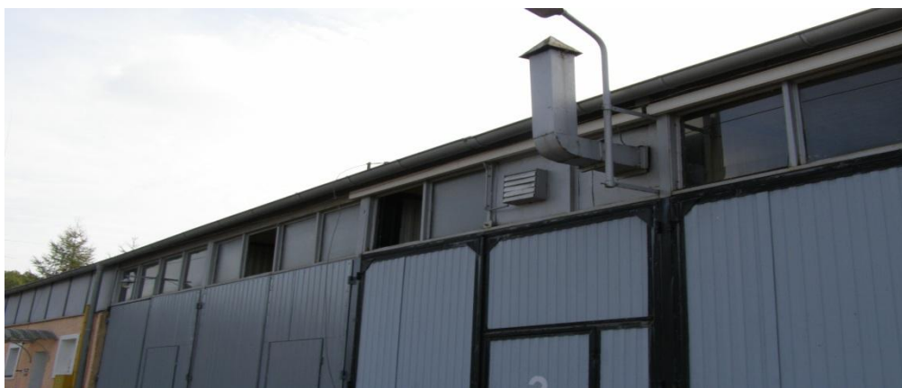
Fot.nr.2. Widok na szeregowo ułożenie okien przeznaczonych do zabezpieczenia antykorozyjnego.
